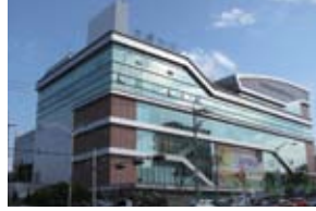
Alışveriş Merkezi / Restoran
